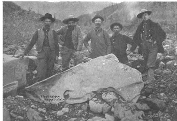
Ilustración 2: Copper River, Alaska, 1903
